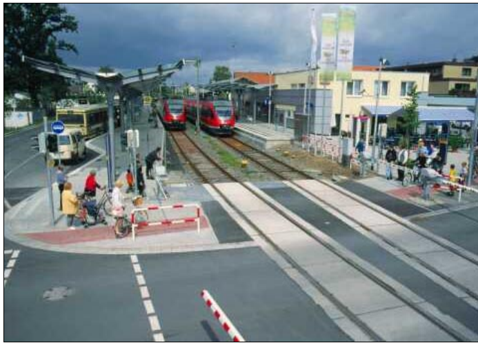
Abbildung 3: Mit SIMIS FFB gesteuerter Bahnübergang in Halle (Westf.)
